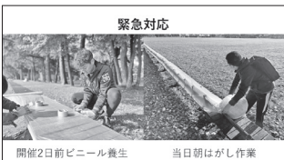
緊急対応 開催2日前ビニール養生 当日朝はがし作業
